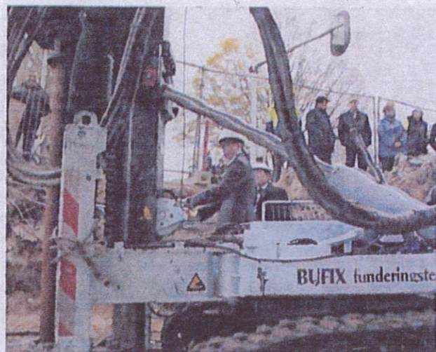
Wethouder Mackus boort de eerste paal voor de verbreding van Brug 15.
